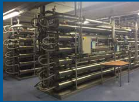
Structure de nanofiltration
